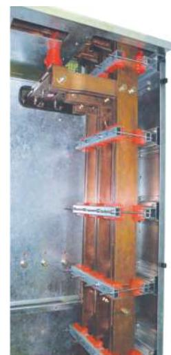
Fixação dos conjuntos de isoladores para fixação lateral coluna de distribuição 2B, 3B, 4A e 4B.
