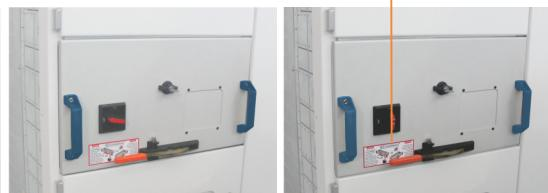
na posição garras de força bloqueada pela chave rotativa e comando inserida.
