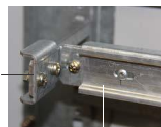
Suporte Horizontal com perfil DIN para fixar disjuntores bornes
